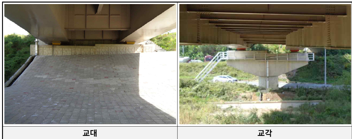
[교대 및 교각 전경]
